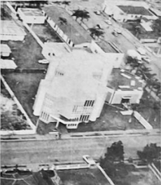
Sede do Poder executivo, o novo prédio chegou em momento oportuno, bem como a ampliação das varas, agora acrescidas de treze juizes.
