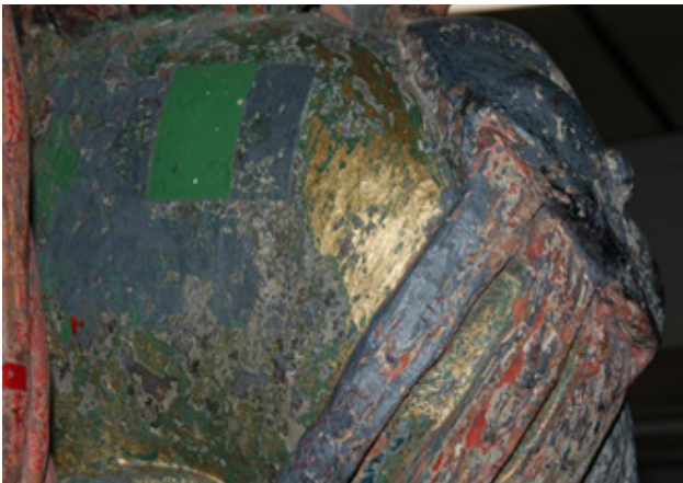
Fig. 4. Detalhe das camadas das tintas.
