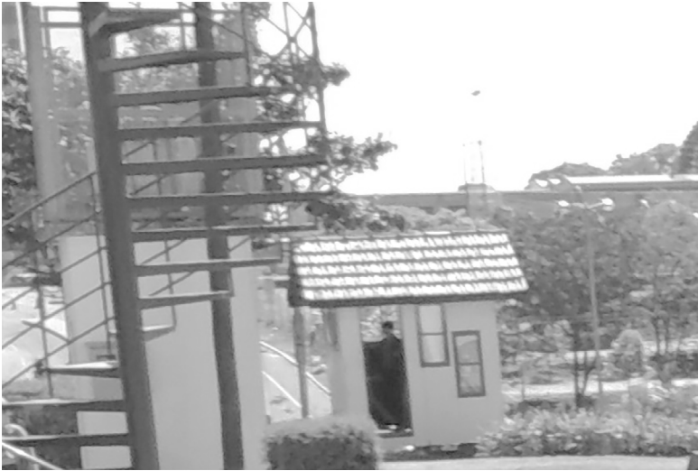
Figura 6. “Casinha do guarda” construída pelos servidores da UFFS.
