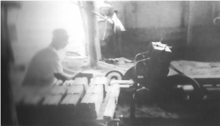
Figura 2. Confeção artesanal do tijolo de seis furos em olaria do meio rural de Passo Fundo. Fonte: Pesquisa de campo.
