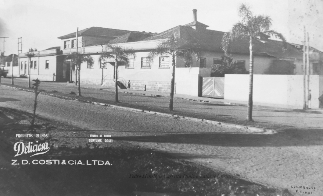
Figura 3. Entrada do Frigorífico Z. D. Costi, no Bairro São Cristóvão. Sem data. Foto Czamanski. Fonte: Museu Histórico Regional.
