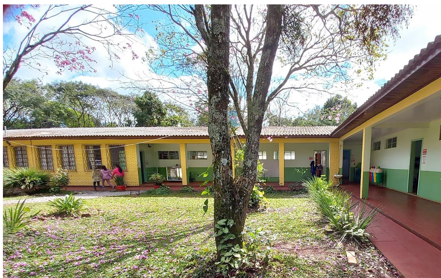
Figura 24. Escola Estadual de Ensino Fundamental 29 de Outubro - Assentamento 16 de Março. Fonte: Fotografia pertencente ao acervo pessoal da autora (2022).
